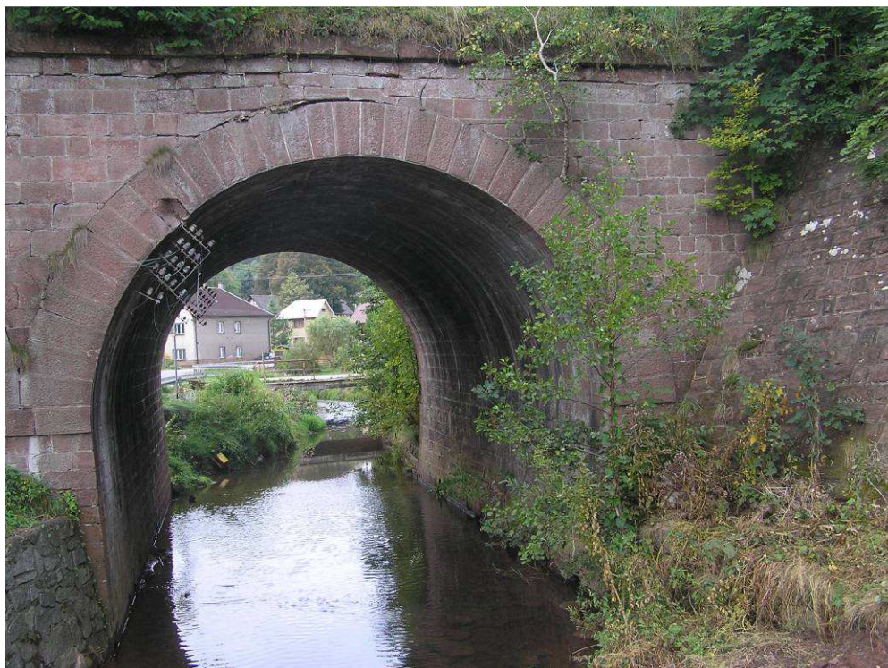
Obr.č.12 Pohled na Olešku v km 75,972.
