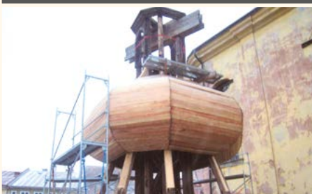
Obnova krovu věže kostela před dokončením
