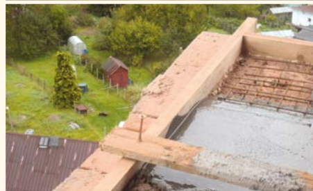
Postupná nadbetonávka římsy věže kostela
