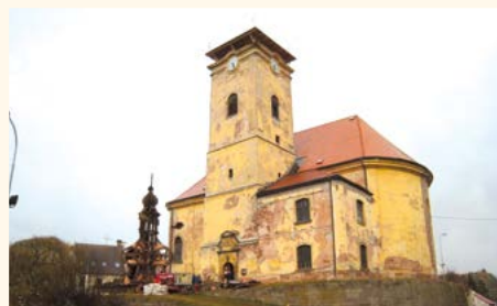
Kostel Nejsvětější trojice před zahájením prací
