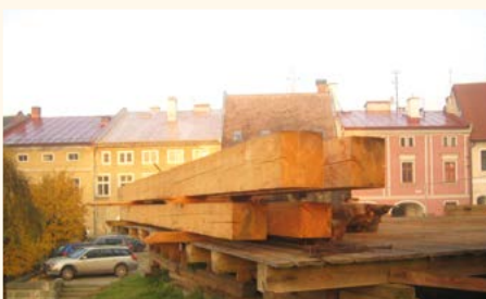
Materiál na obnovu spodního křížce
