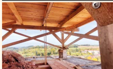
Dokončená sanace římsy věže kostela
