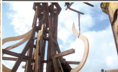
Montáž ramenátů do konstrukce krovu věže
