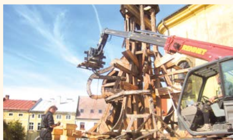
Demontáž poškozených prvků věže kostela
