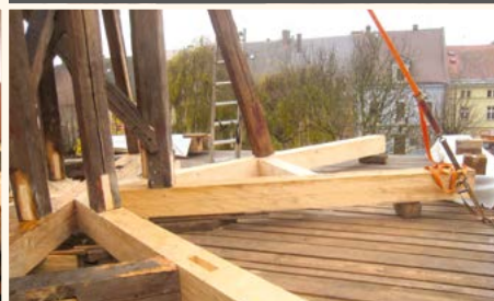
Obnova spodního křížce věže
