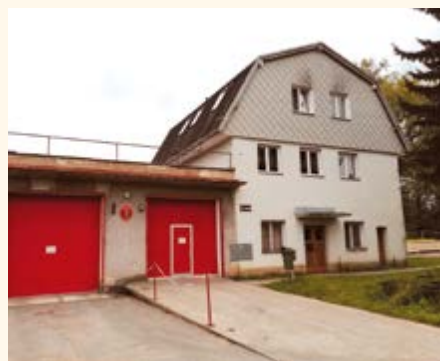
Požární zbrojnice a byty, č. p. 151. Foto T. Voborník
