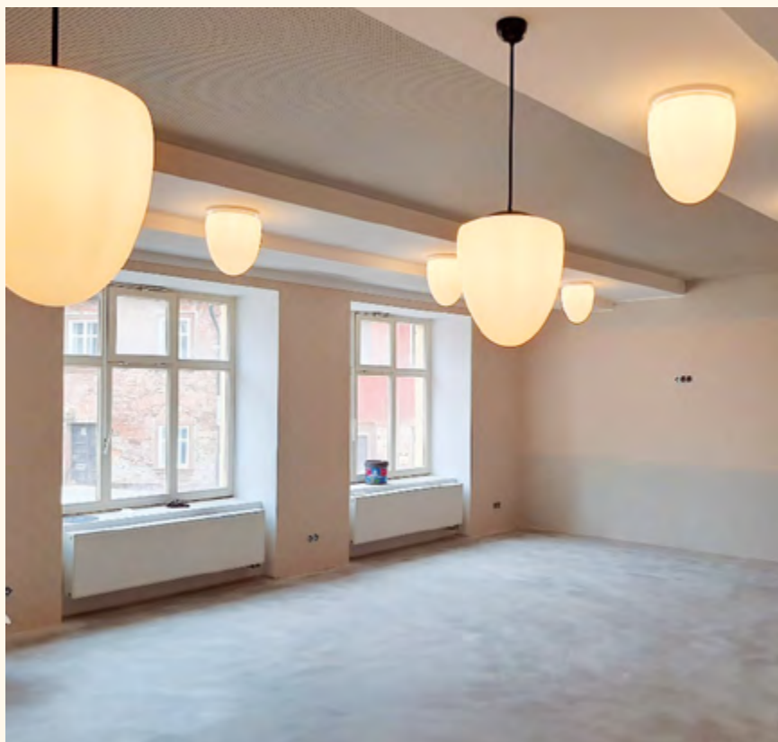
Rekonstrukce restaurace Slunce. Foto J. Červený
