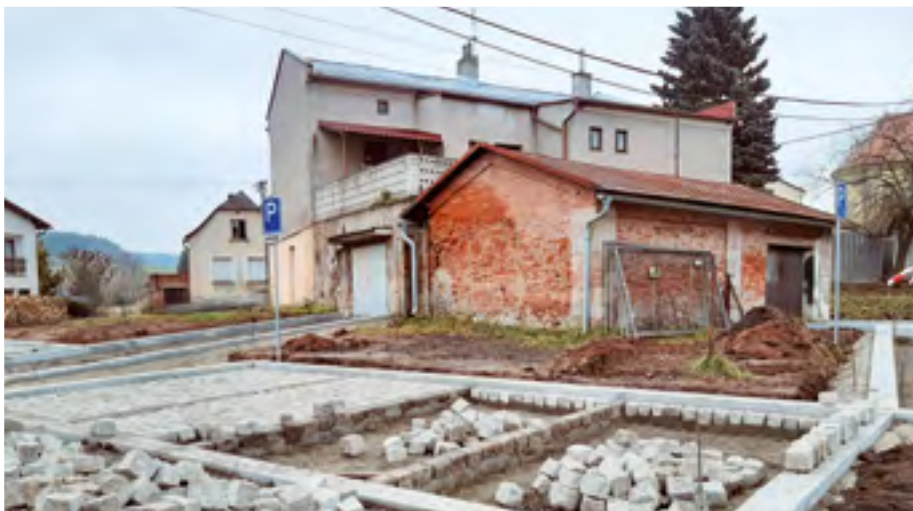
Kontrola při budování parkoviště pod poštou. Foto J. Červený
