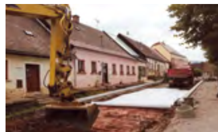
Oprava státní komunikace I/16. Foto T. Voborník
