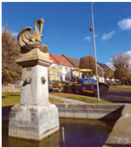
Kontrola při pokládání asfaltu na hlavní komunikaci. Foto J. Červený
