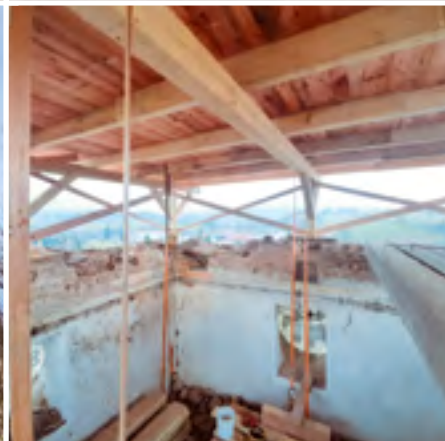
Sundání kupole kostela. Foto L. Kulková a J. Červený
