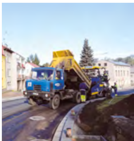
Oprava státní komunikace I/16. Foto T. Voborník
