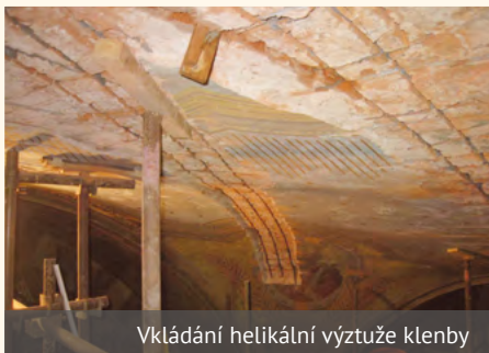
Lešení podpírající klenbu nad presbytářem
