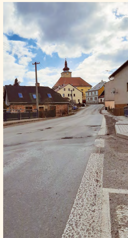
Rozbitá silnice. Foto J. Červený
