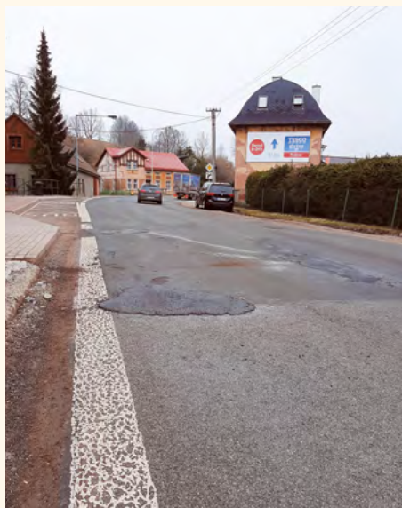
Dočasné opravy. Foto J. Červený
