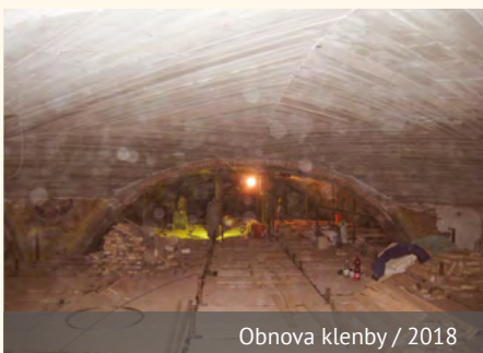
Lešení podpírající klenbu nad presbytářem
