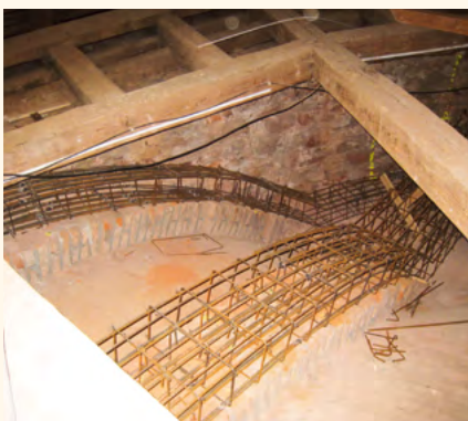
Výztuž pasů klenby nad presbytářem
