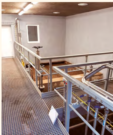
Interiér ČOV po rekonstrukci. Foto T. Voborník
