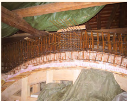
Celkový pohled na výztuž podélného pasu
