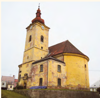
Stav kostela před zahájením prací v roce 2020
