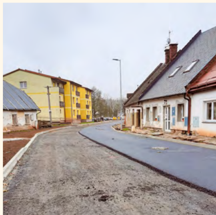
Oprava komunikace na Hradčíně. Foto J. Červený
