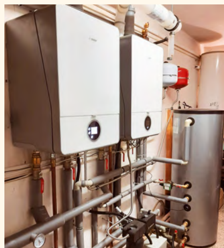
Škola má také nové plynové kotle. Foto J. Červený
