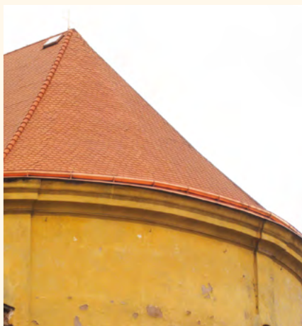
Opravená střecha nad lodí a presbytářem
