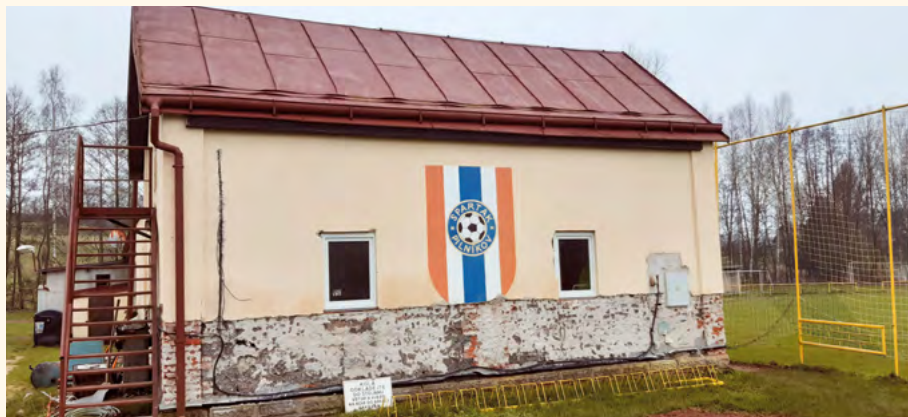
Práce na rekonstrukci budovy v areálu fotbalového hřiště probíhají svépomocí. Foto: P. Mihálka
