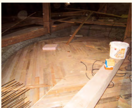
Dokončené bednění klenby
