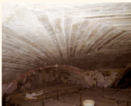
Pohled na novou klenbu po dokončení
