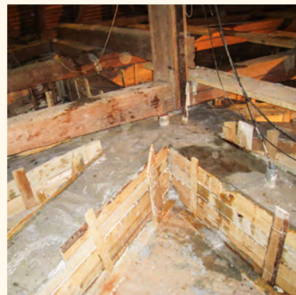
Betonáž ztužujících žebér klenby
