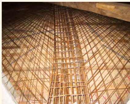
Výztuž nové klenby
