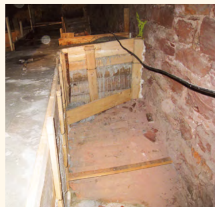
Dokončený podélný obrubní pas
