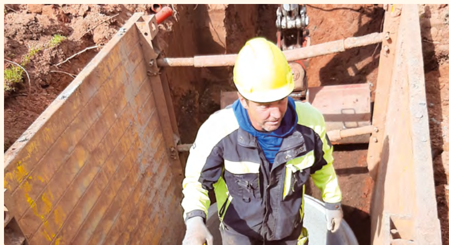
Příprava kanalizace. Foto J. Červený
