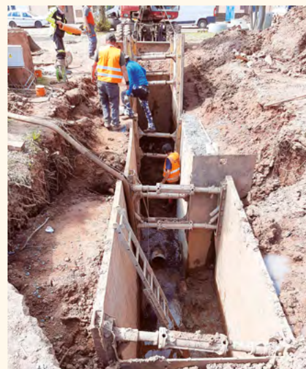
Příprava kanalizace. Foto J. Červený
