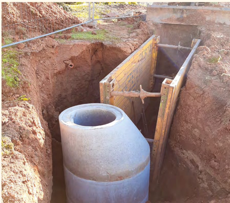
Příprava kanalizace. Foto J. Červený
