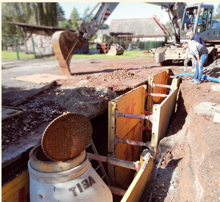
Příprava kanalizace. Foto T. Voborník
