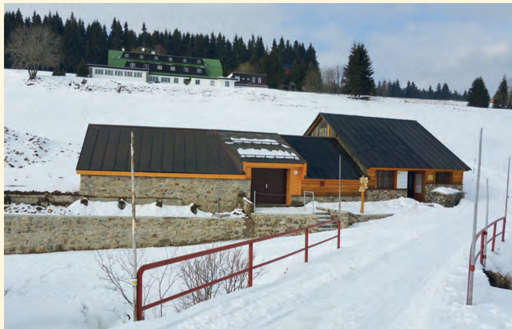
ČOV Horní Malá Úpa
