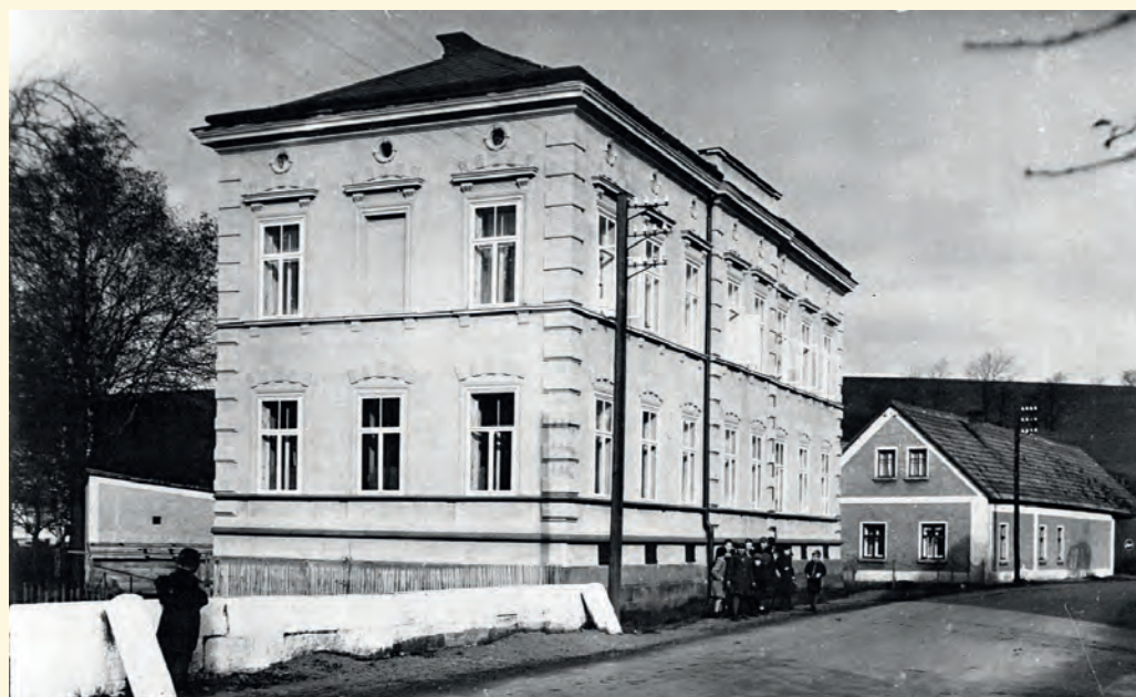
Školní budova v Trutnovské ulici č.p. 50 v roce 1932
