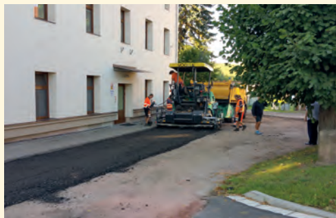
Oprava příjezdové plochy před MŠ (foto: M. Klapka)
