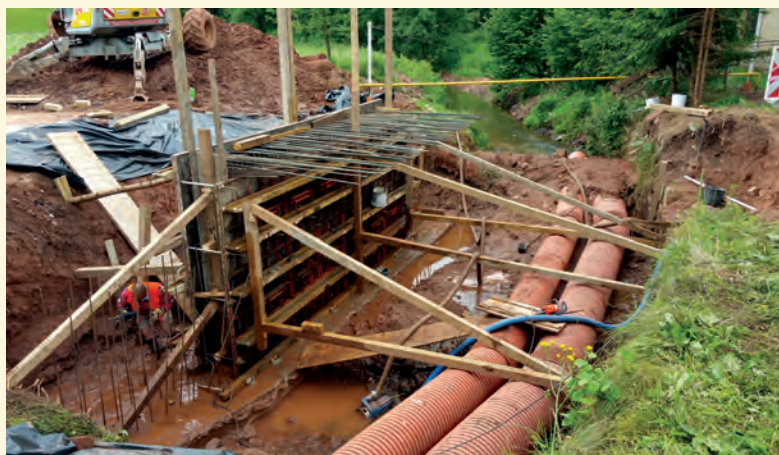
Betonářské práce při výstavbě mostní opěry
