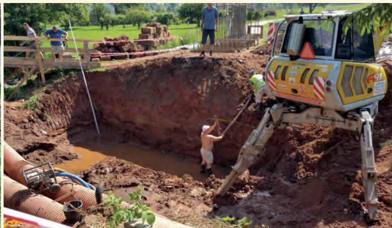
Svedení toku za pomoci kanalizačních trub a příprava základové plochy
