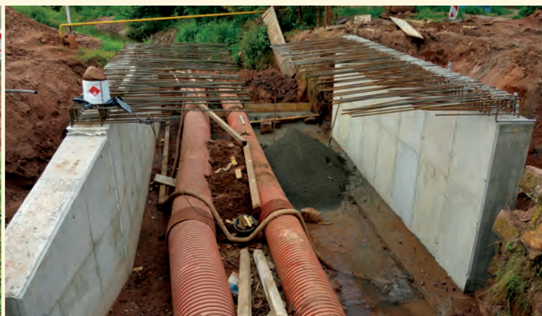
Příprava armatur pro betonáž mostovky
