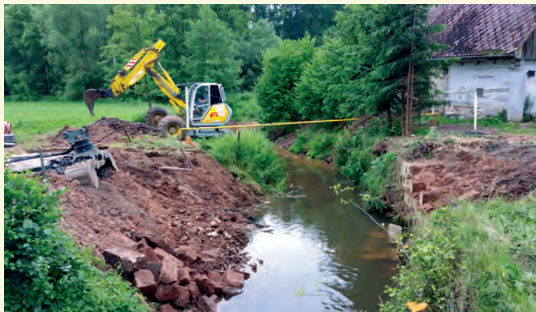
Demolice a odstranění starých základů mostu
