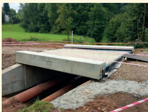
Úprava předpolí mostu a komunikace
