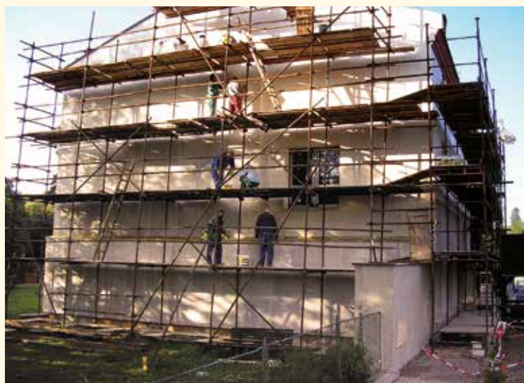
Práce při zateplování obvodových stěn
