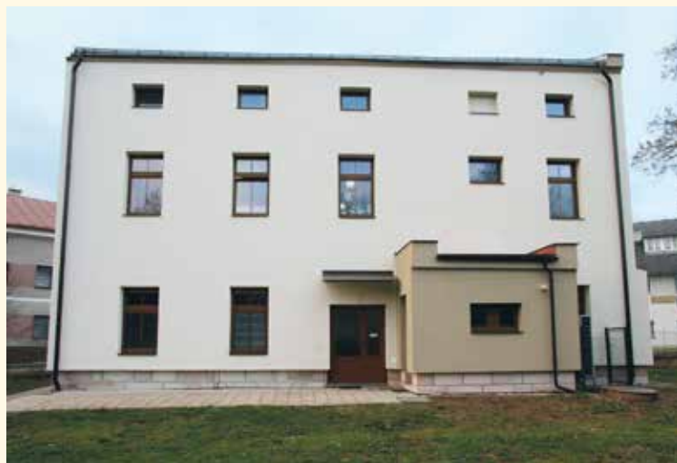
Mateřská škola po rekonstrukci - pohled ze zahrady
