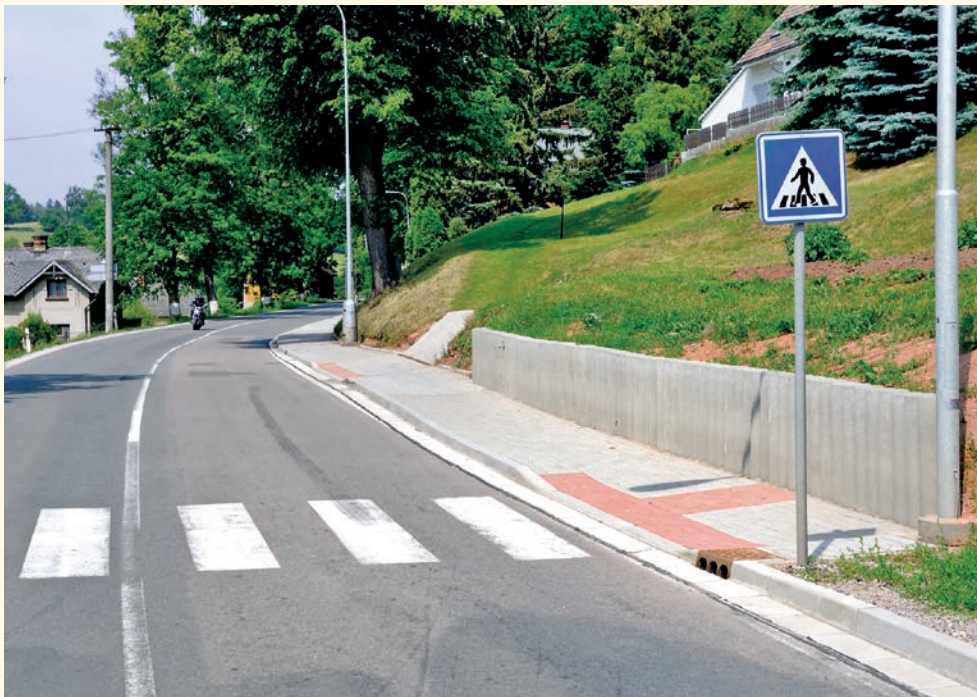
Nový chodník s opěrnou zdí a přechodem pro pěší
