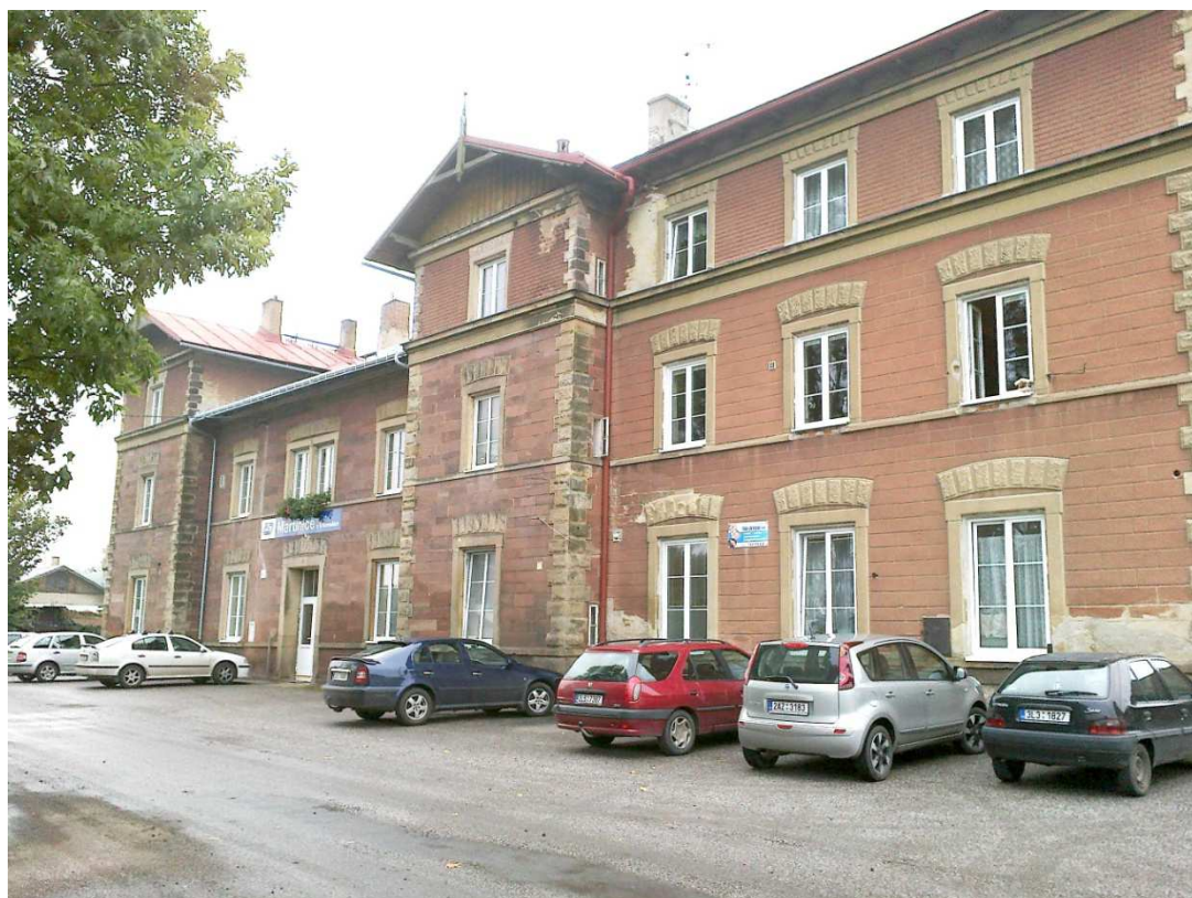
Obr. 2 – výpravní budova v Martinicích s byty
