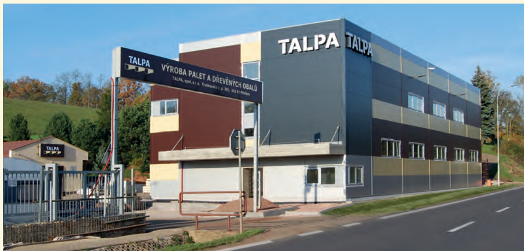
Nová hala společnosti TALPA, spol. s r.o.
